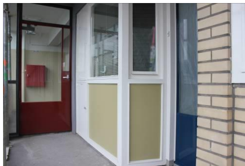
Afb. 6.4 Impressie van de kleuren op de galerijdeuren van flat blok III. Foto: auteur
