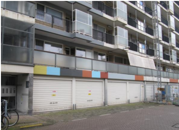
Afb. 6.7 Testkleuren op blok 7, voor de schilderwerkzaamheden in 2014. Foto: auteur.
