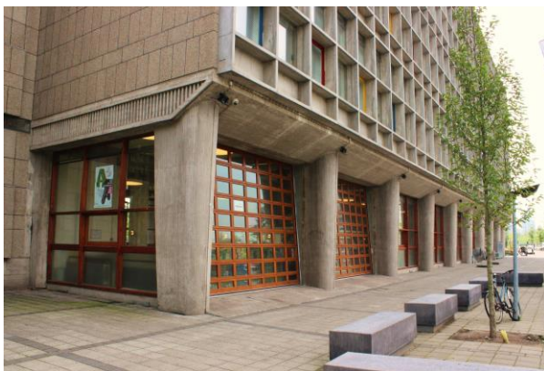
Afb. 3.6 Detail betonnen kolommen begane grond met daartussen kaal houtwerk. Foto: auteur
