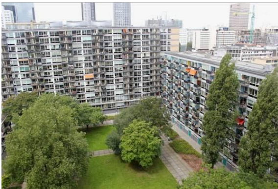
Afb. 6.1 Lijnbaanflats Blok III (links) en Blok 7 (rechts). Foto: auteur
