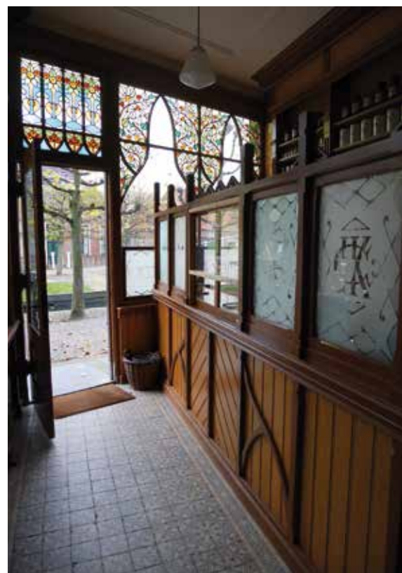
Gematteerd glas en glas in lood in het interieur van de apotheek.
