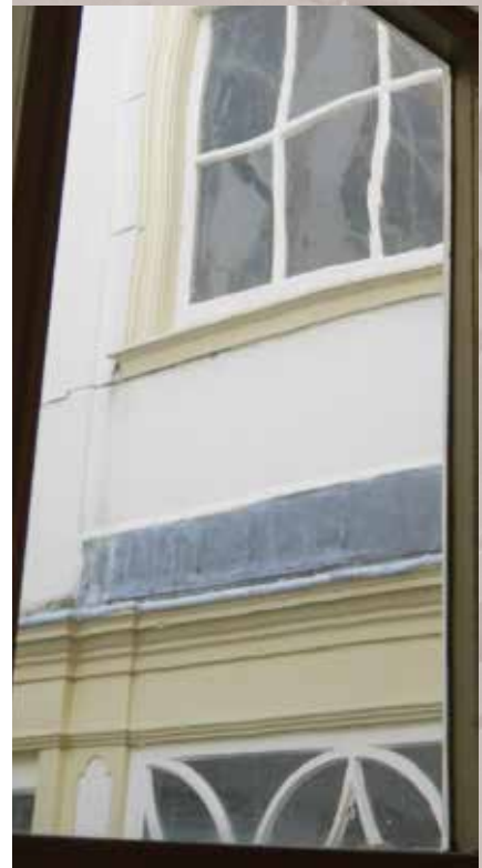
Langwerpige, golvende vervorming en ovale luchtbel in cilinderglas, Huis van Brienen, Amsterdam
