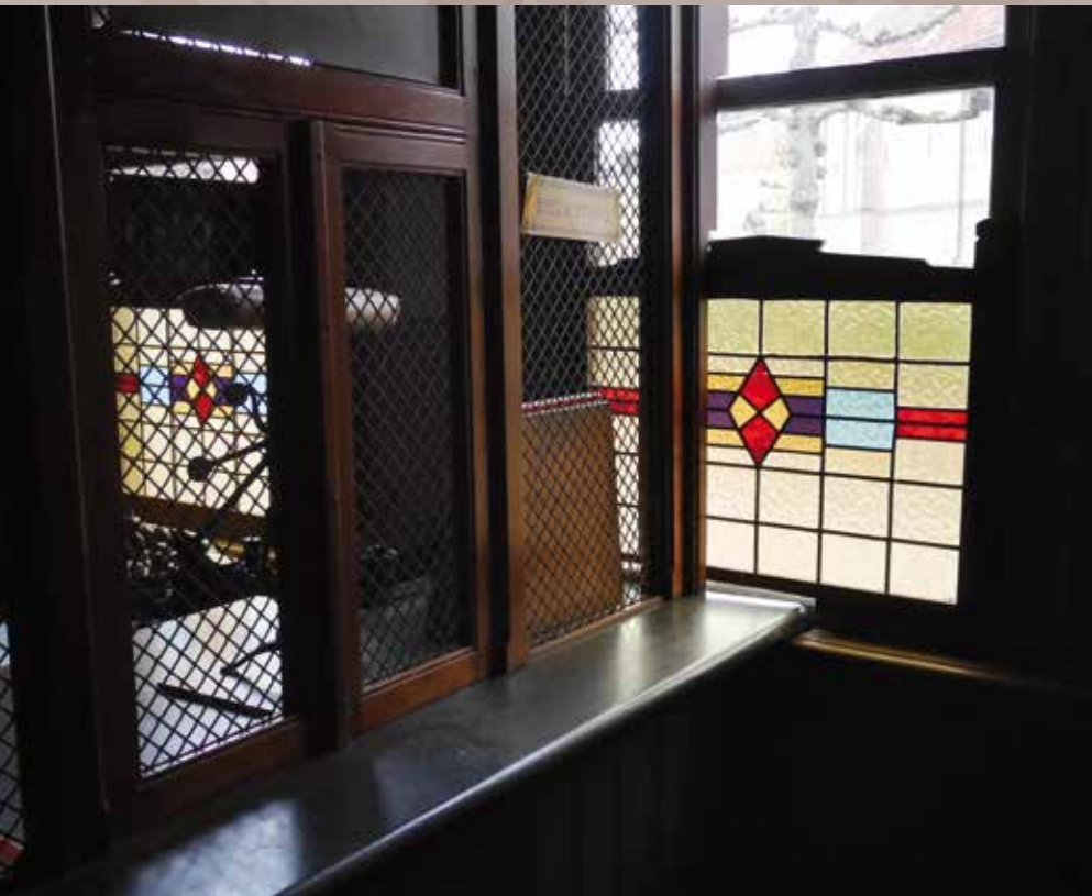
Glas in lood voorzetramen met structuurglas in het postkantoor.
